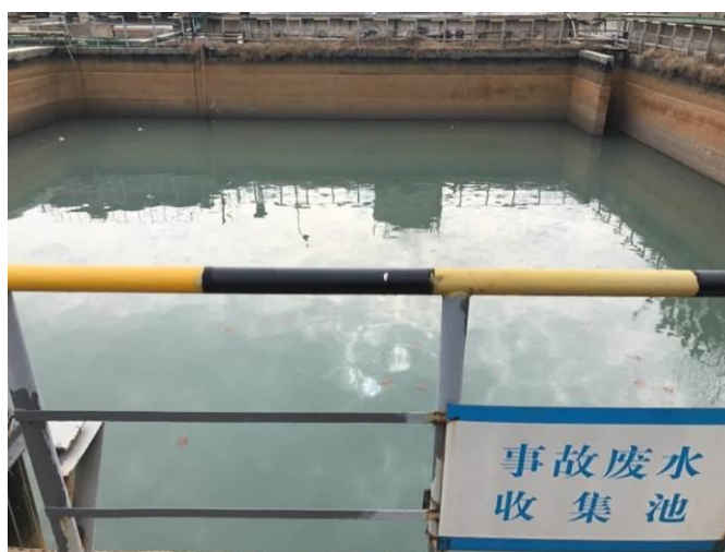
图3-6 事故废水收集池
