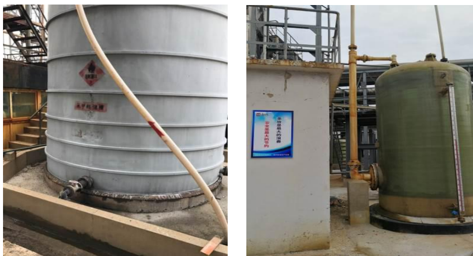
图3-3 储罐围堰
